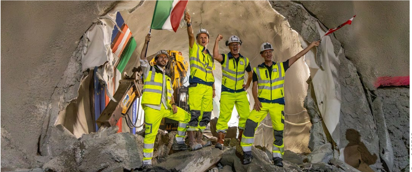
Durchschlag unterhalb des Brennerpasses - Jubel beim Projektteam vom Baulos Pfnos-Brenner
