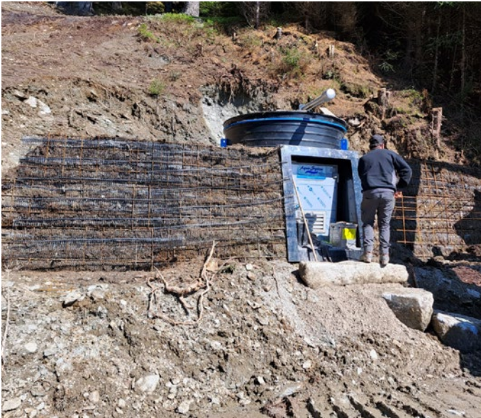
Sanierung der Quelle 5
