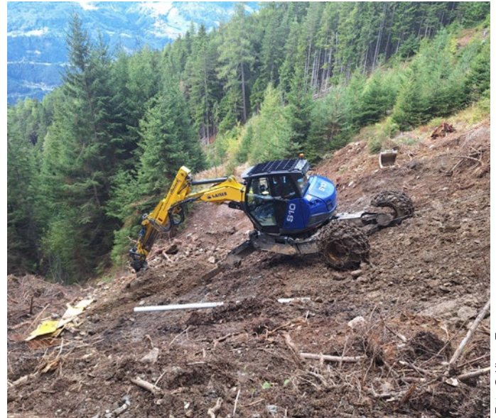
Sanierung der Quelle 6
