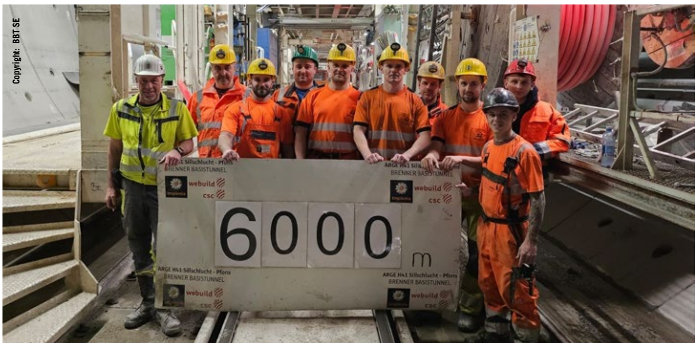
Brenner Basistunnel: Baulos H41 Sillschlucht-Pfons: Die Vortriebsmannschaft der Tunnelbohrmaschine „Ida“ freut sich über den neuen Vortriebsstand von 6000 Meter.
